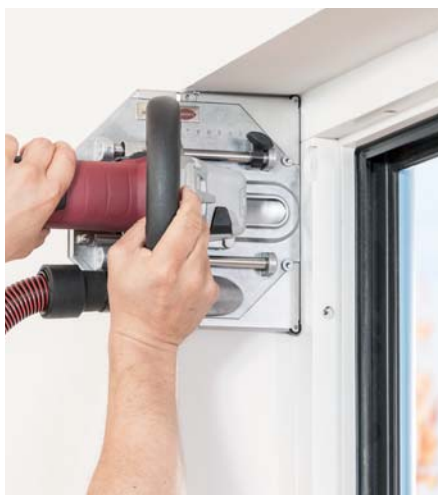
Zaagsnede in houten kozijnen
