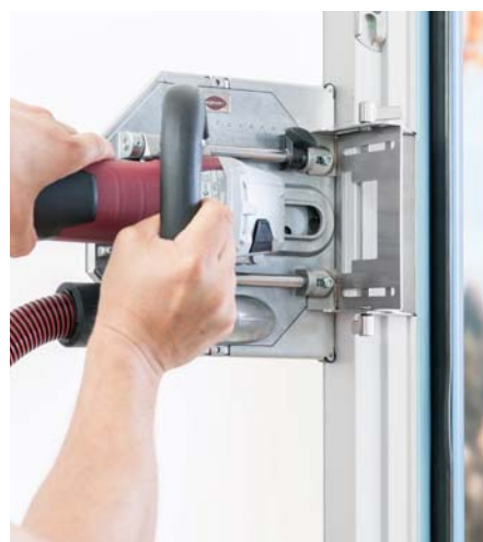
Zaagsnede met de sponningaanslag
