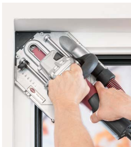
Zaagsnede langs het raamkozijn
