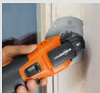
Metalen bevestigingsbanden bij de demontage van oude ramen doorsnijden.
