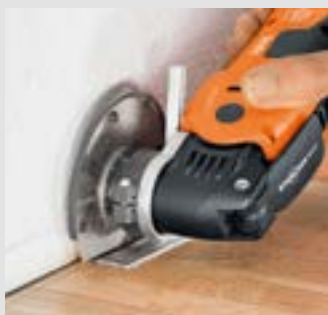
Uitzetvoegen kunnen uitstekend achteraf worden gesneden.
