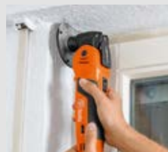
Afdekkingen van rolluikbakken opensnijden.
